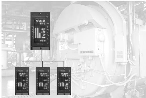
PlantPAK es un paquete pre-diseñado y pre-programado que proporciona un punto de ajuste común para múltiples calderas en el mismo cabezal. El PlantPAK funciona en conjunto con sistemas de control de caldera SteamPAK o con sistemas de terceros.
